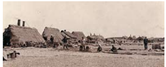
▲納屋建てと同じ構造の鯛小屋（戦前）
