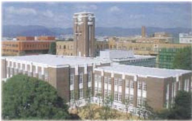
京都大学建築本部本館（通称時計台）
