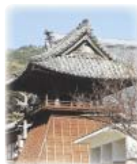
かつて模造梵鐘が吊り下がっていた西円寺の鐘楼(しょうろう)
