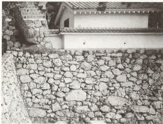
●田原城で最も古い石垣（下側）
