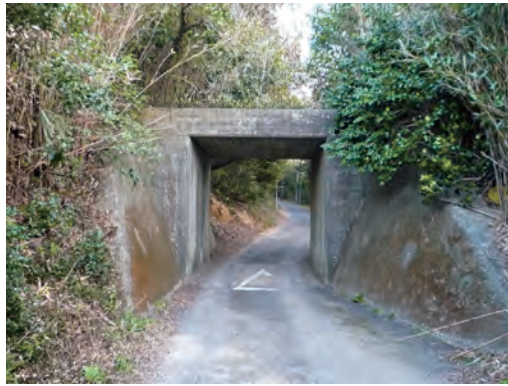
国による渥美線建設工事の遺構である石神町に残るコンクリート橋 現在
